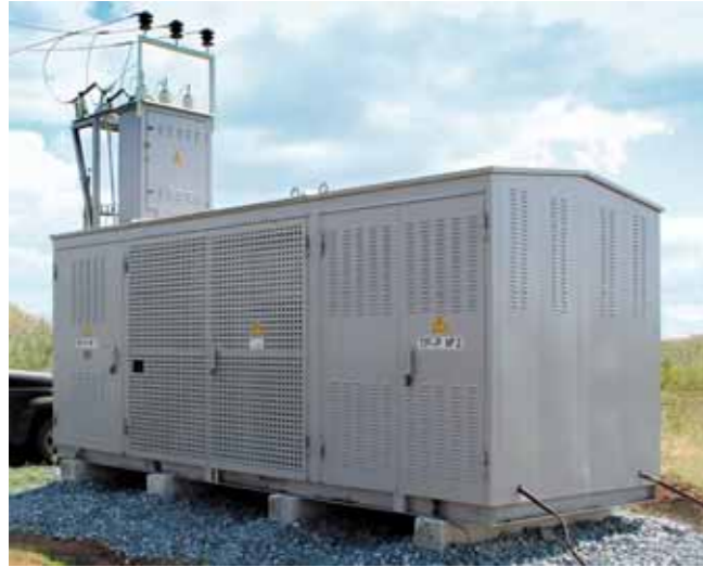
Внешний вид КТППН в транспортном положении
